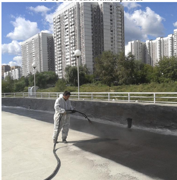
56-15-СЛ. Ремонт эксплуатируемой кровли
