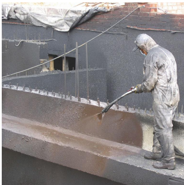
21-08-FL. Монолитный фундамент
