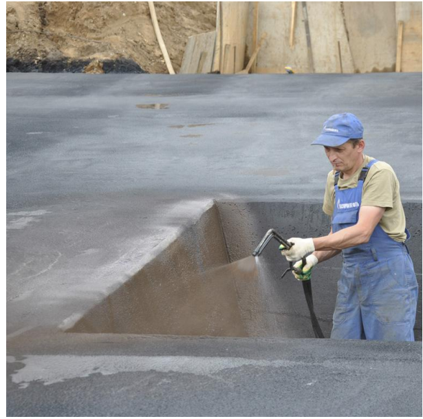
64-17-RF. Фундаментная плита с приямком
