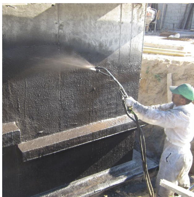
36-12-RF. Фундаментные стены
