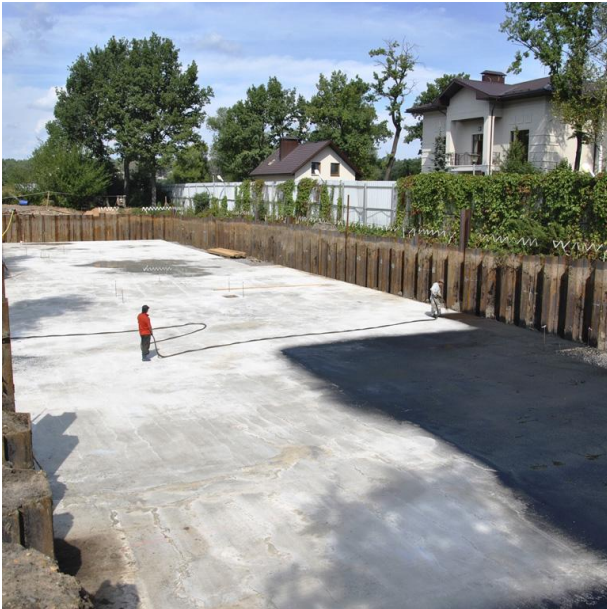
47-13-RF. Основание бассейна
