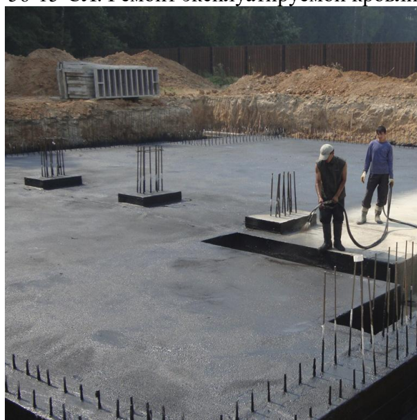
30-10-FL. Фундаментная плита
