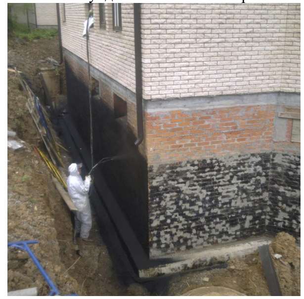
41-13-RF. Ремонт гидроизоляции фундамента
