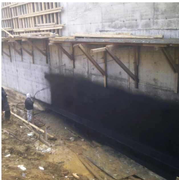
48-13-RF. Фундаментные стены
