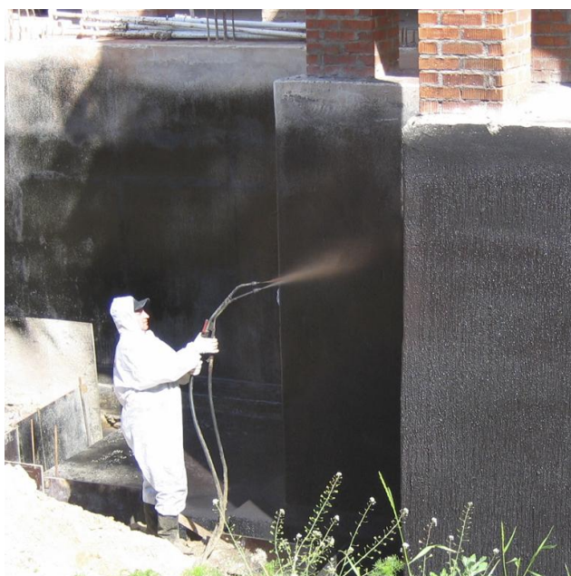
19-08-FL. Фундаментные стены
