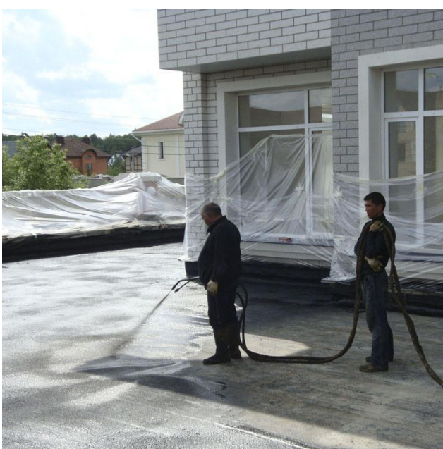
26-09-FL. Ремонт кровли
