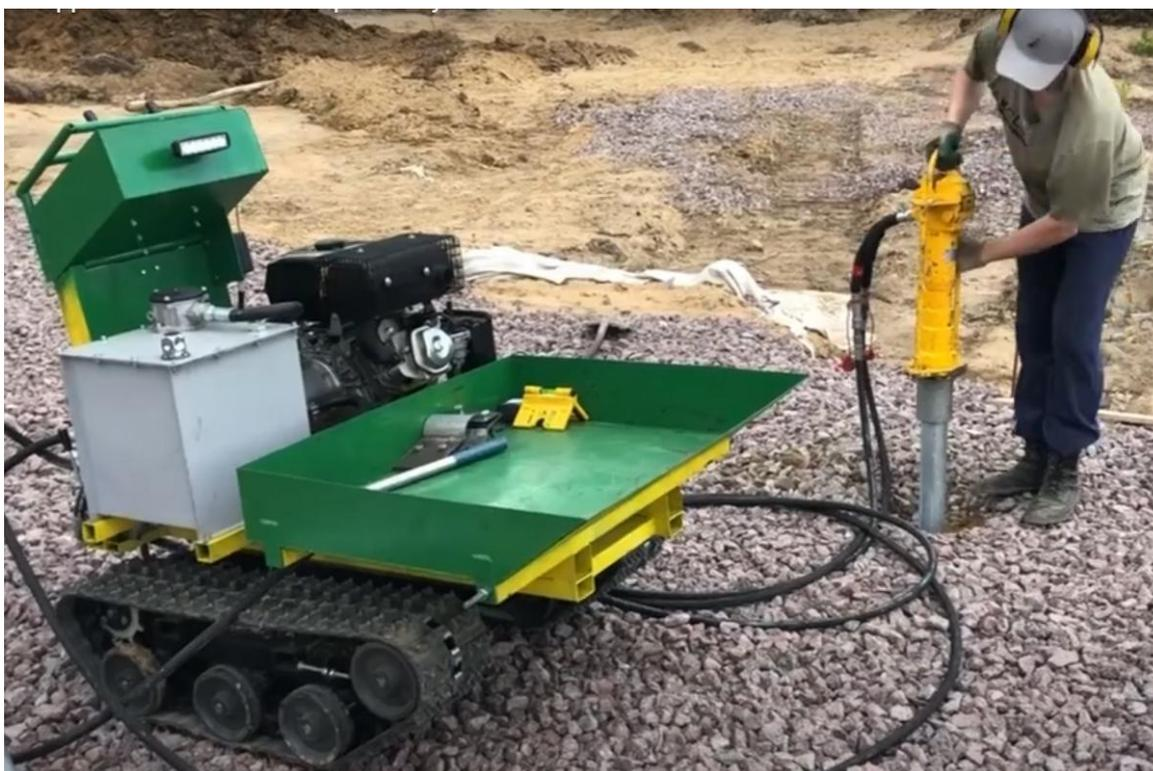
Устанавливаем на сваю гидравлический копер. Стержень надёжно фиксируется в гнезде цилиндрического адаптера. Если свая квадратного сечения, то используется другой адаптер. Выравниваем сваю по уровню под 90 градусов к поверхности земли и начинаем забивать.
