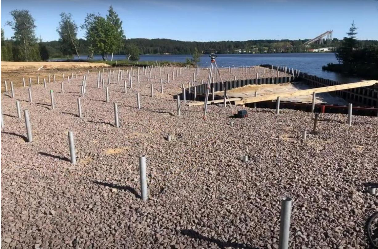
После того, как убедились, что все опоры вошли в грунт на правильную глубину, верхние части всех свай обрезаются в один уровень на указанную в проекте высоту. К вершине каждой сваи приваривается оголовок «СОМ».
